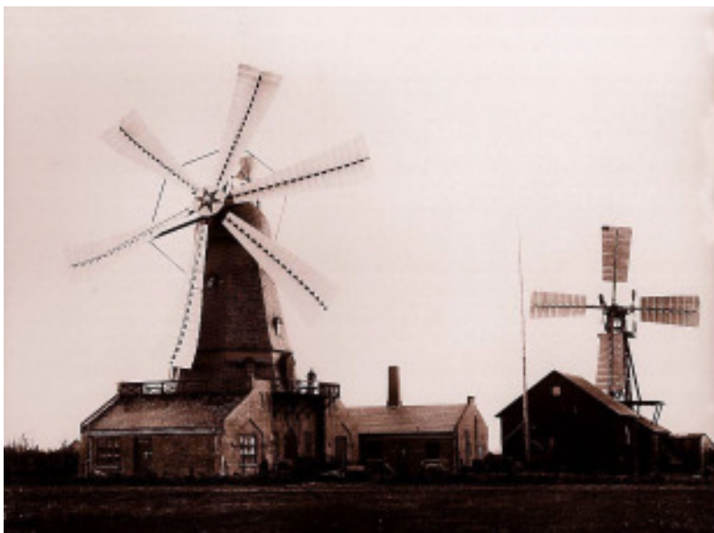
Twee windturbines, ontwerp Poul la Cour, Askov, Denemarken, foto uit 1897
